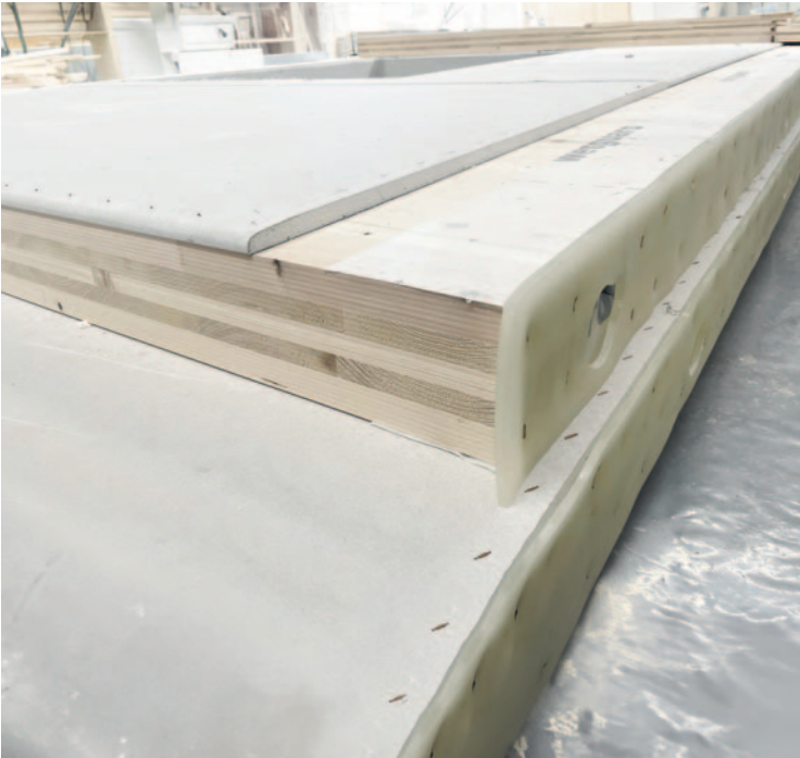
CLT Elemente, beplankt mit GKF Platten, Feuchteschutz am Wandfuß mittels SIGA Wetguard sowie vormontierten PU- Schallschuttlagern (Rothoblaas XYLOFON)
