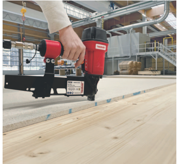
Beplankung einer CLT Wand mit Fermacell GF Platten
