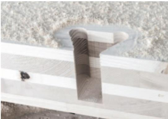
Fräbung in CLT für X-Fix C
